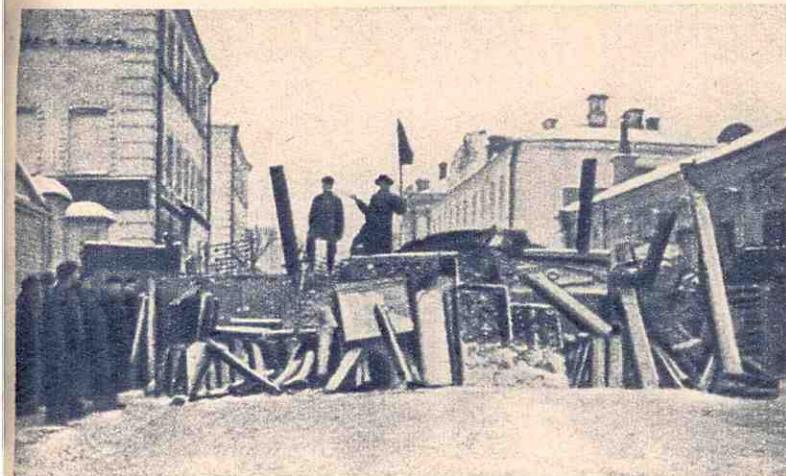
Баррикады в Москве на Малой Бронной улице в дни декабрьского вооруженного восстания. (Фото из фондов Государственного музея Революции СССР.)
